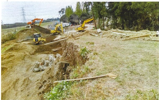
早侯地区堤防決壊復旧工事
